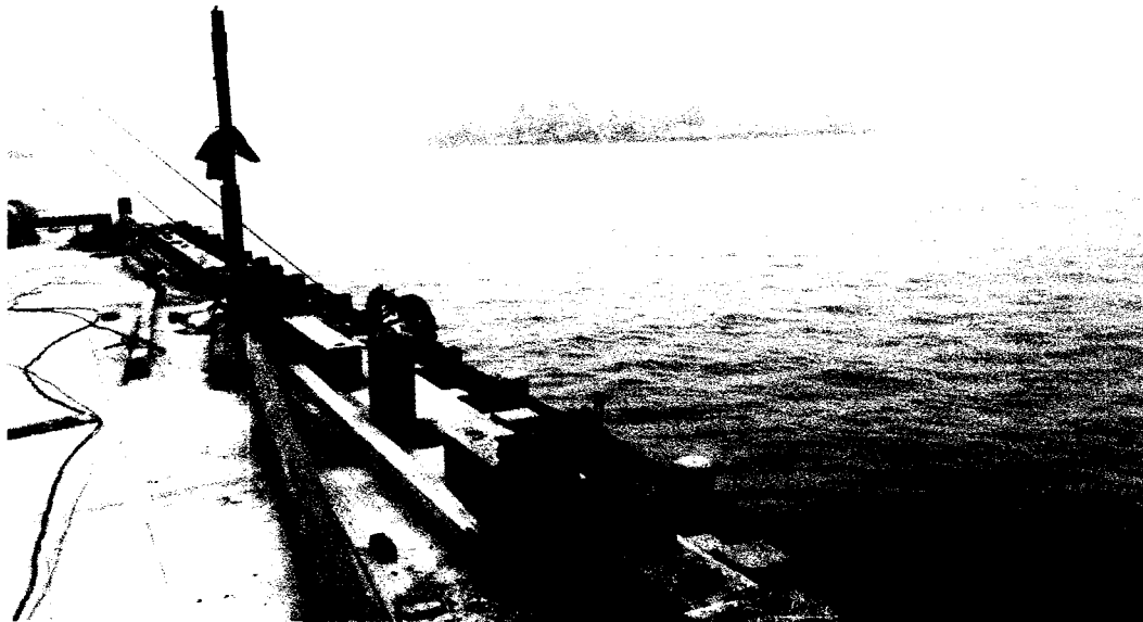
1.- Inicio de trabajo en montaje
